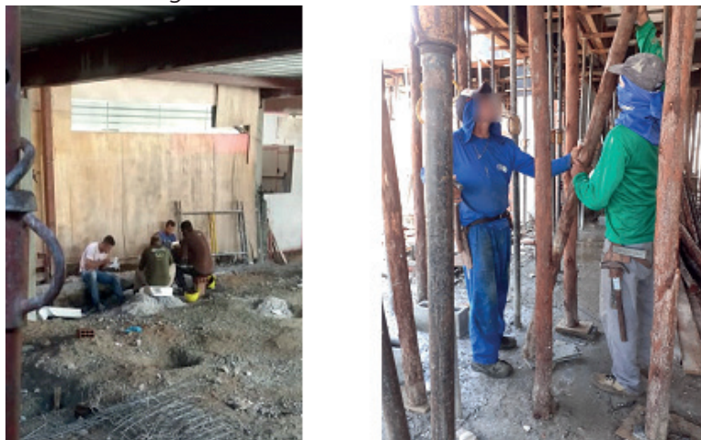
Figura 2 – Trabalhadores aglomerados, sem distanciamento e uso das máscaras
