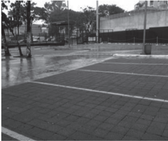
Figura 9 – Estacionamento revestido parcialmente com pavimento permeável
