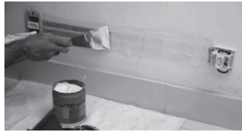
Figura 4 – Solução Instalação de tomadas (Eletrofita)
