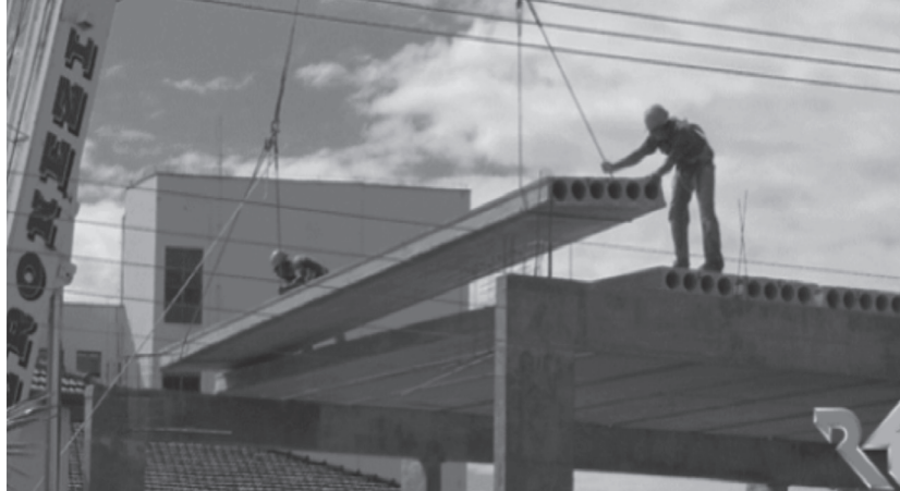
Figura 5 – Içamento e montagem de laje alveolar
