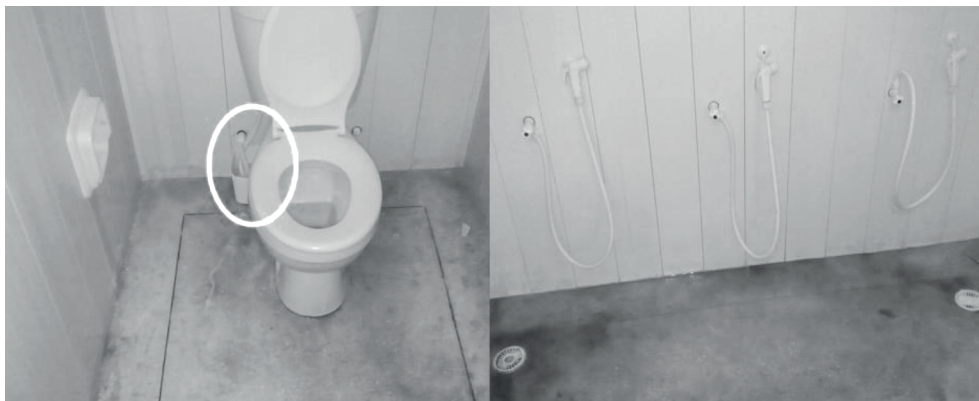
Figura 4 – Banheiros na escola B
