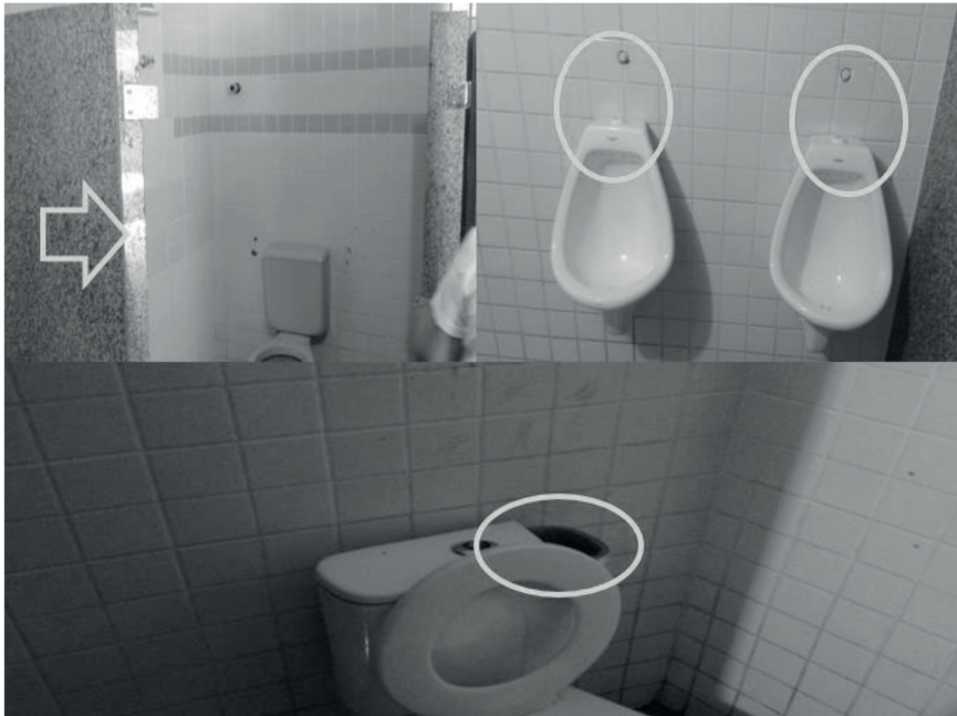
Figura 6 – Banheiros escola C
