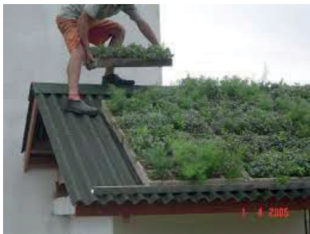
Figura 3 – Colocação de placas
