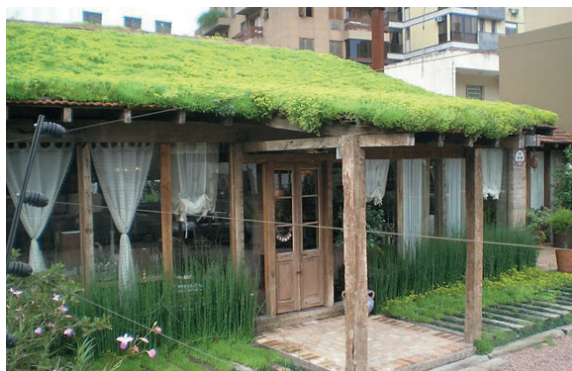
Figura 2 – Residência com telhado verde contínuo
